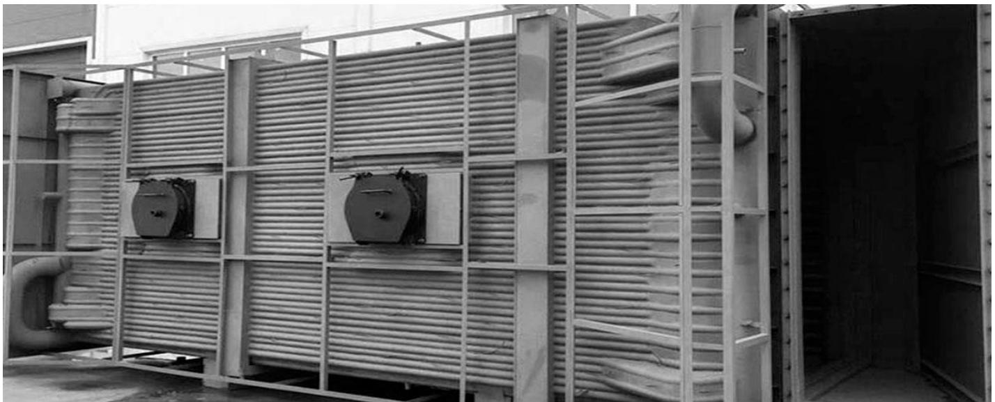
Котлы серии ПТВМ предназначены для получения горячей воды с температурой до 150 °С в отдельно стоящих котельных для использования в системах отопления, вентиляции и горячего водоснабжения объектов промышленного и бытового назначений и на ТЭЦ.
