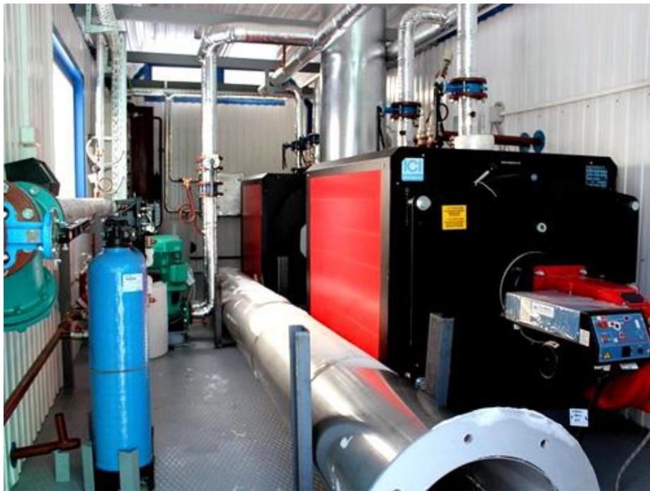
**Передвижная котельная установка (ПКУ)** представляет собой блок-модуль полной заводской готовности, установленный на шасси. Котельная может работать на жидком, твёрдом топливе или электричестве.
